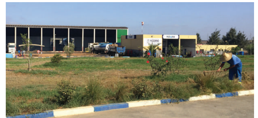
Hall de réception des déchets
