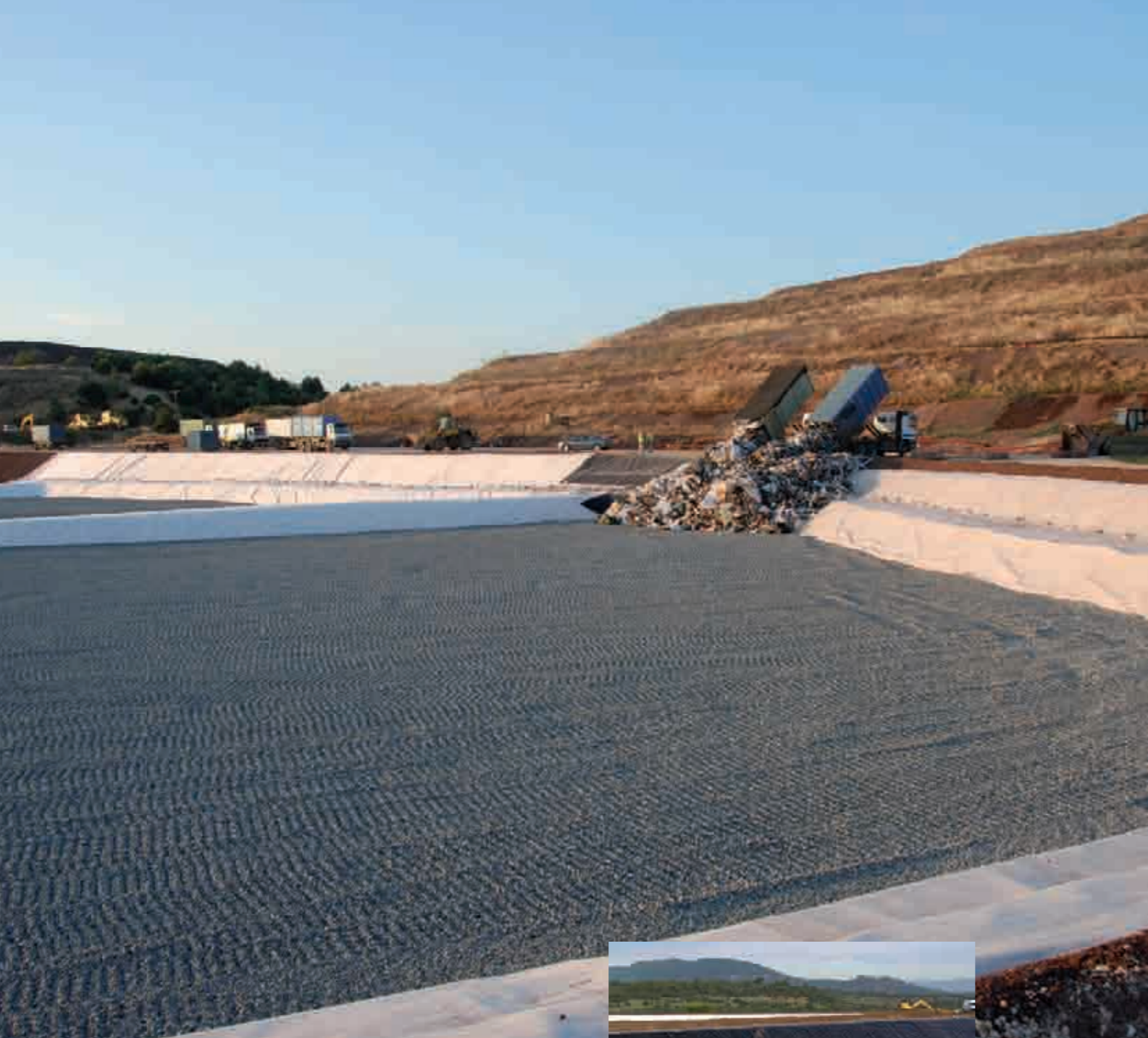
Arrivée des premiers déchets au I.S.D.N.D. du Balançon
