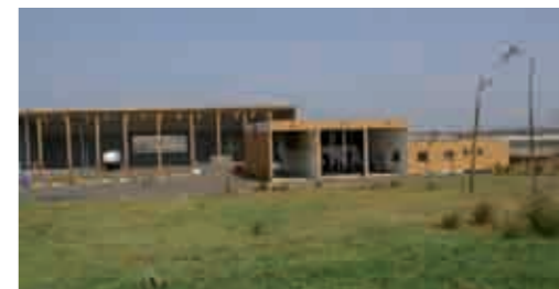
Centre de traitement d'Oum Azza au Maroc.
