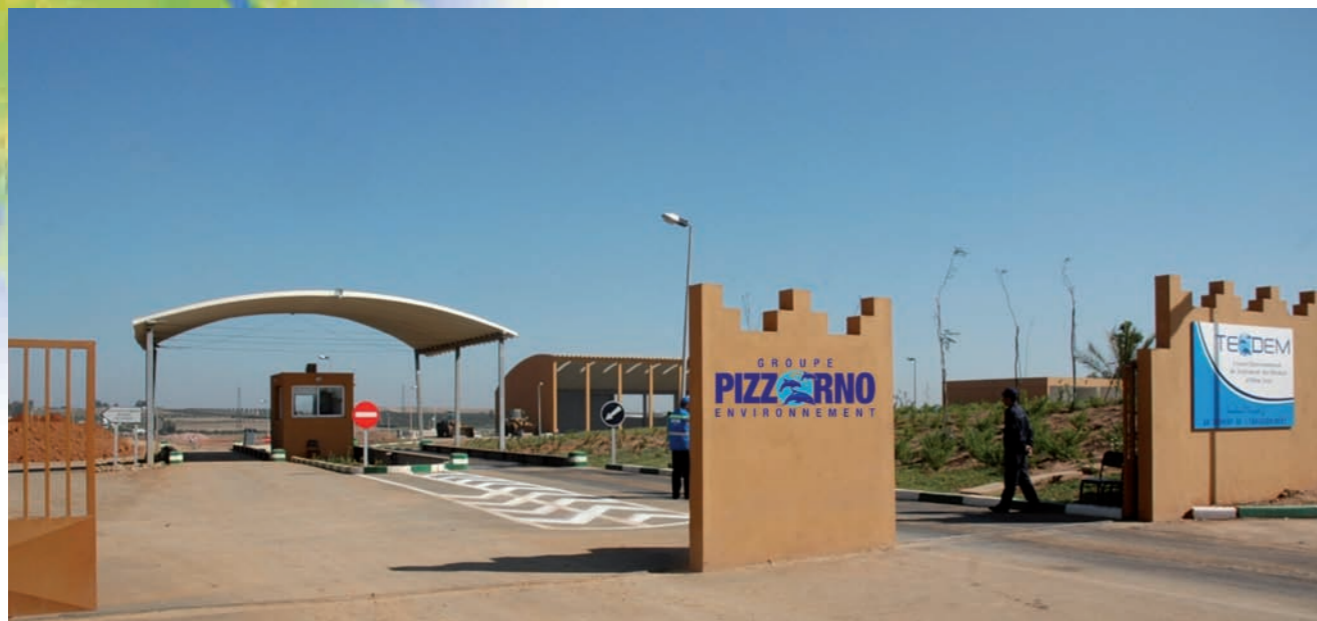
Centre de traitement d'Oum Azza au Maroc.
